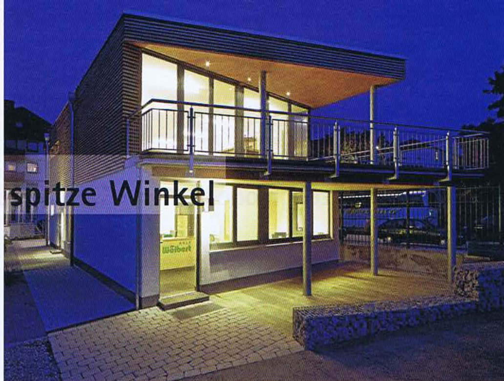
Das Dortmunder Unternehmen Sperrholz Wölbert setzte bei seinem neuen Büro- und Kommunikationsgebäude auf Holzrahmenbauweise.
