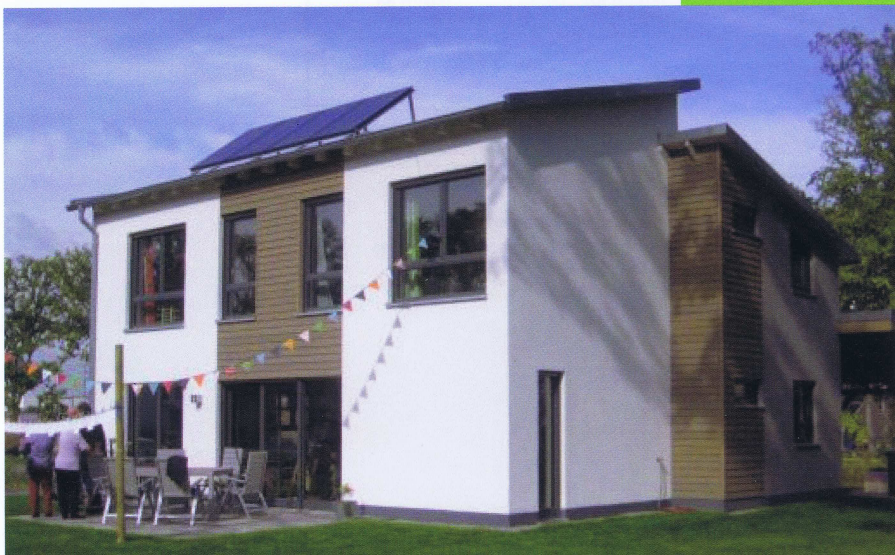
Anschauung zum Holzbau gibt es im Paul Schnitker-Haus — Demonstrationzentrum Bau und Energie der Handwerkskammer Münster
